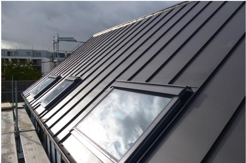
Une toiture en zinc oxydée - http://www.briero.fr/
