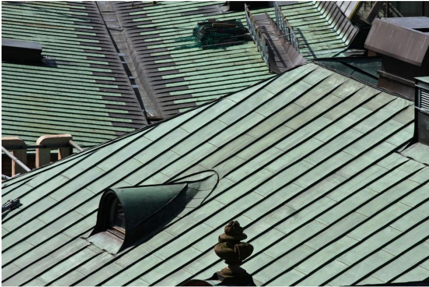
Un toit recouvert d'oxyde de cuivre (vert de gris) – http://www.dasilvacarlos.fr/
